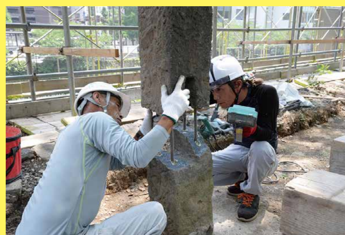
4 折損した控石柱の補修作業
