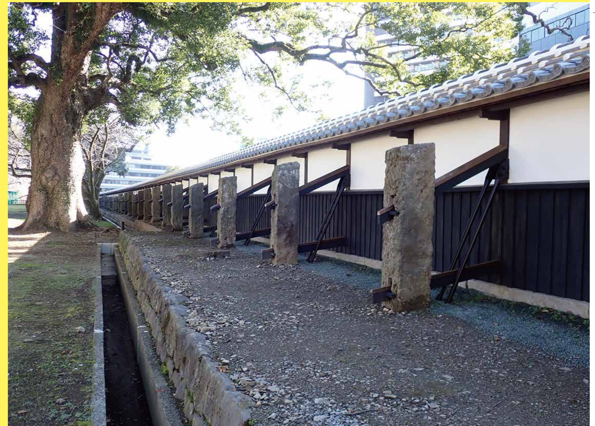
5 復旧完了後の長堀(城内側)
