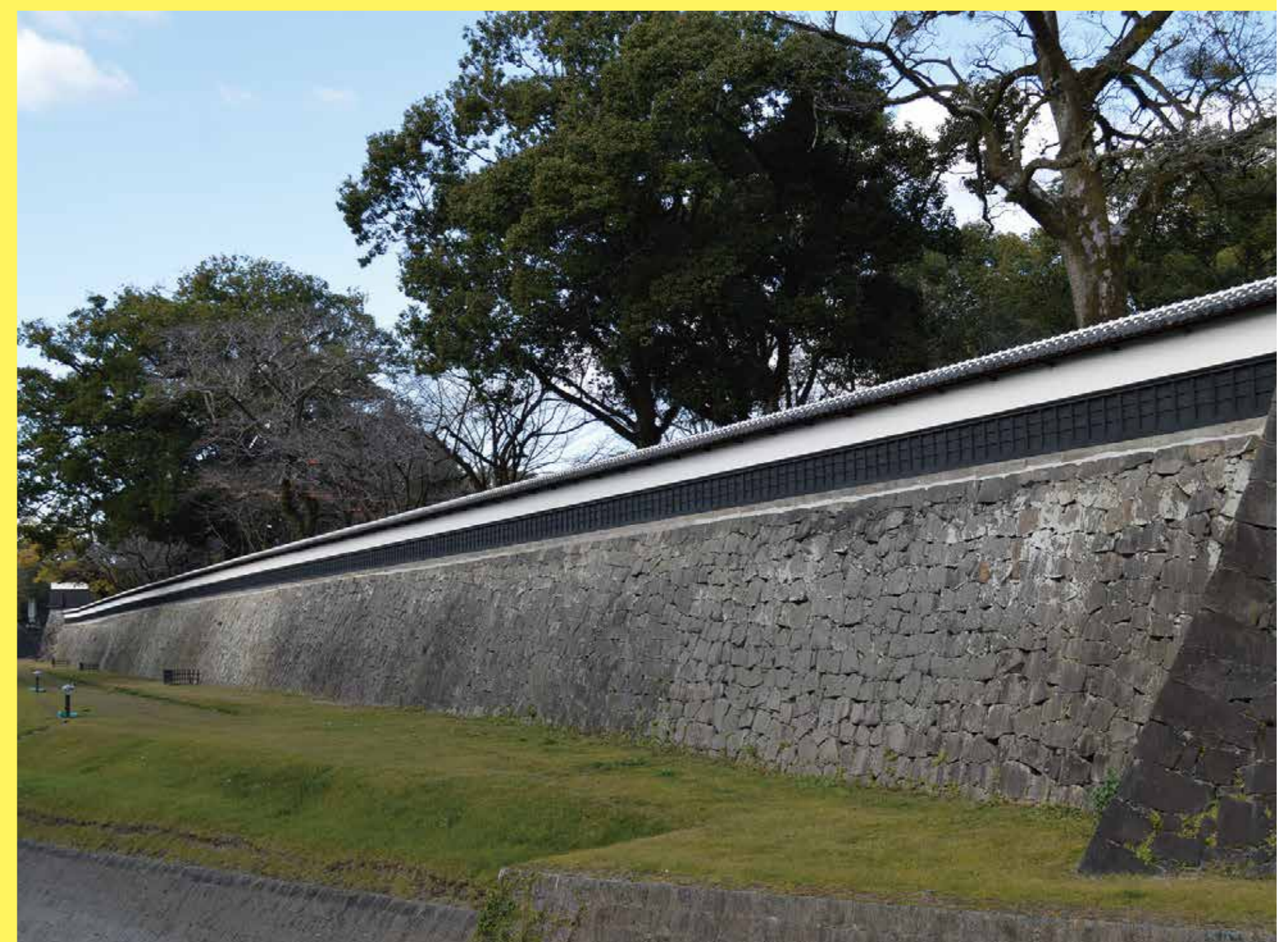
5 復旧完了後の長堀
