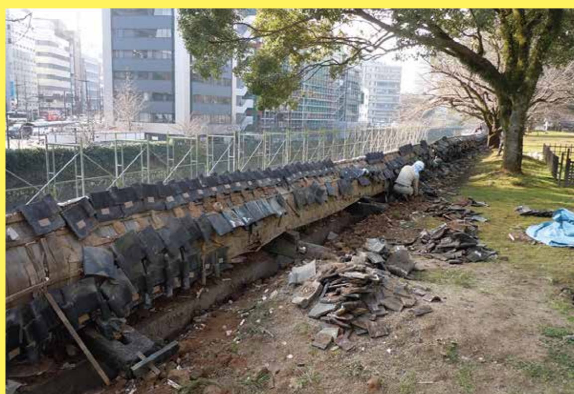
2 解体中の長堀
