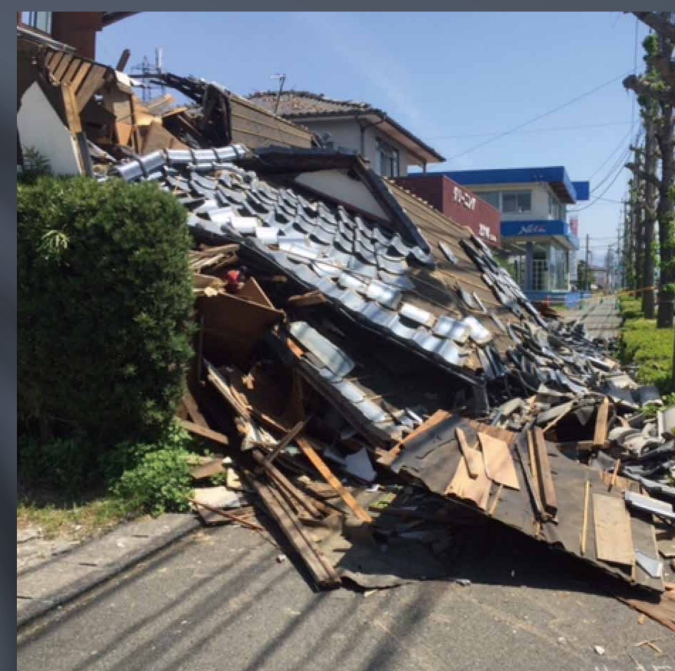
熊本市東区沿道の崩壊した住宅
