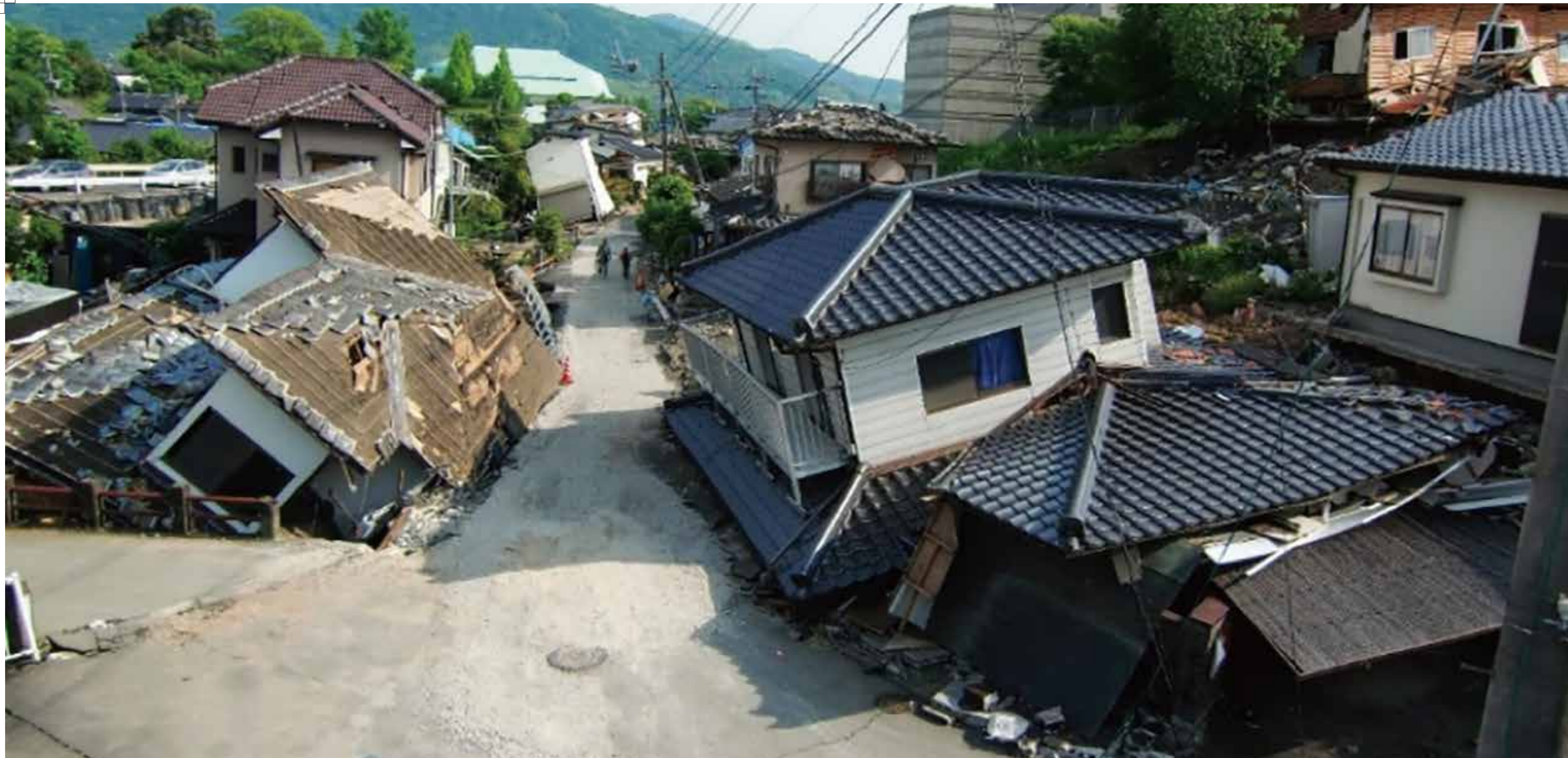
地震直後の民家倒壊状況
