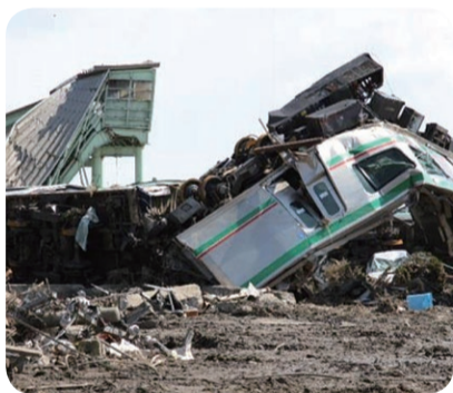
JR新地駅の被災状況
